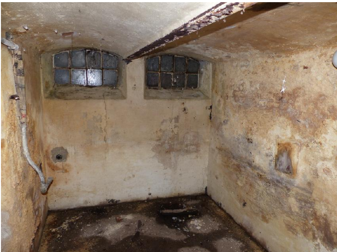
Abbildung 10: Feuchter Kellerraum im Gebäude Süderstraße 24, Spuren einer Quartiernutzung wurden nicht festgestellt
