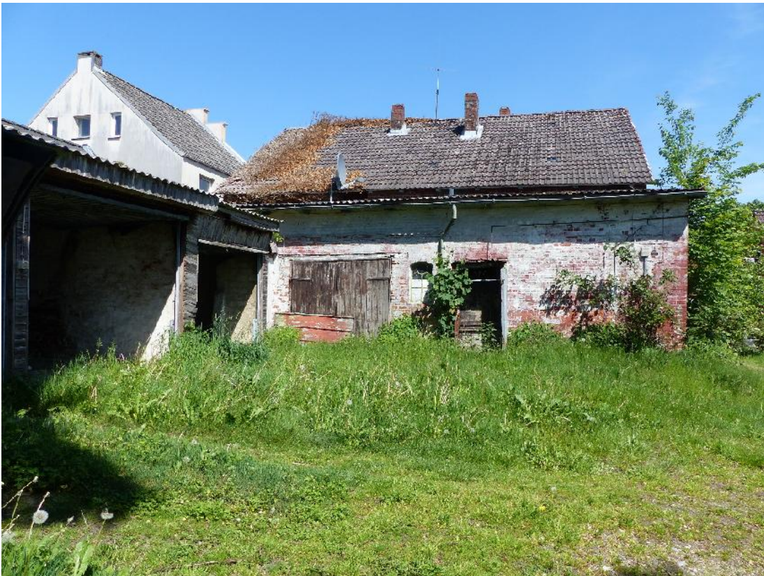
Abbildung 4: Gebäude Süderstraße 24 mit Garagenanbau, Blickrichtung Ost
