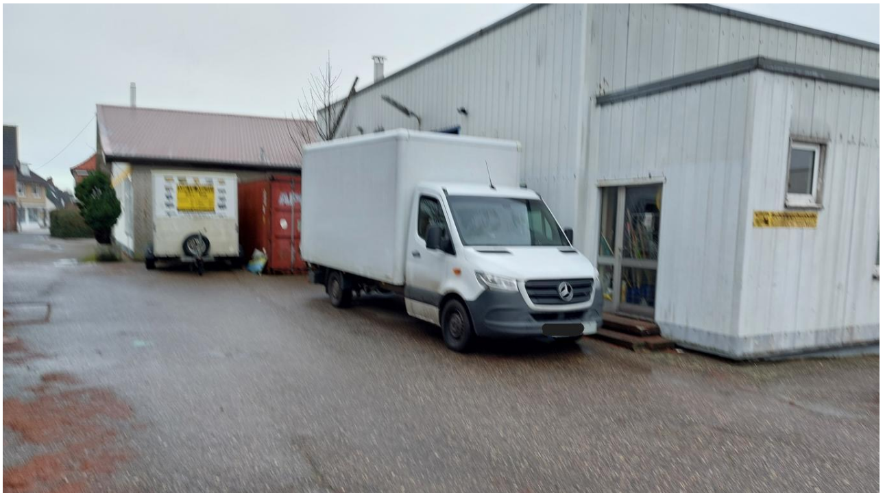
Foto 2: Blick nach NNE, Blick auf die nördl. Werkstatthalle (KVF01) (Aufnahmedatum: 09.01.2025)
